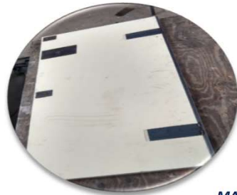
PISOS reforzados con tablas de Saligna estacionada y FENOLICO
